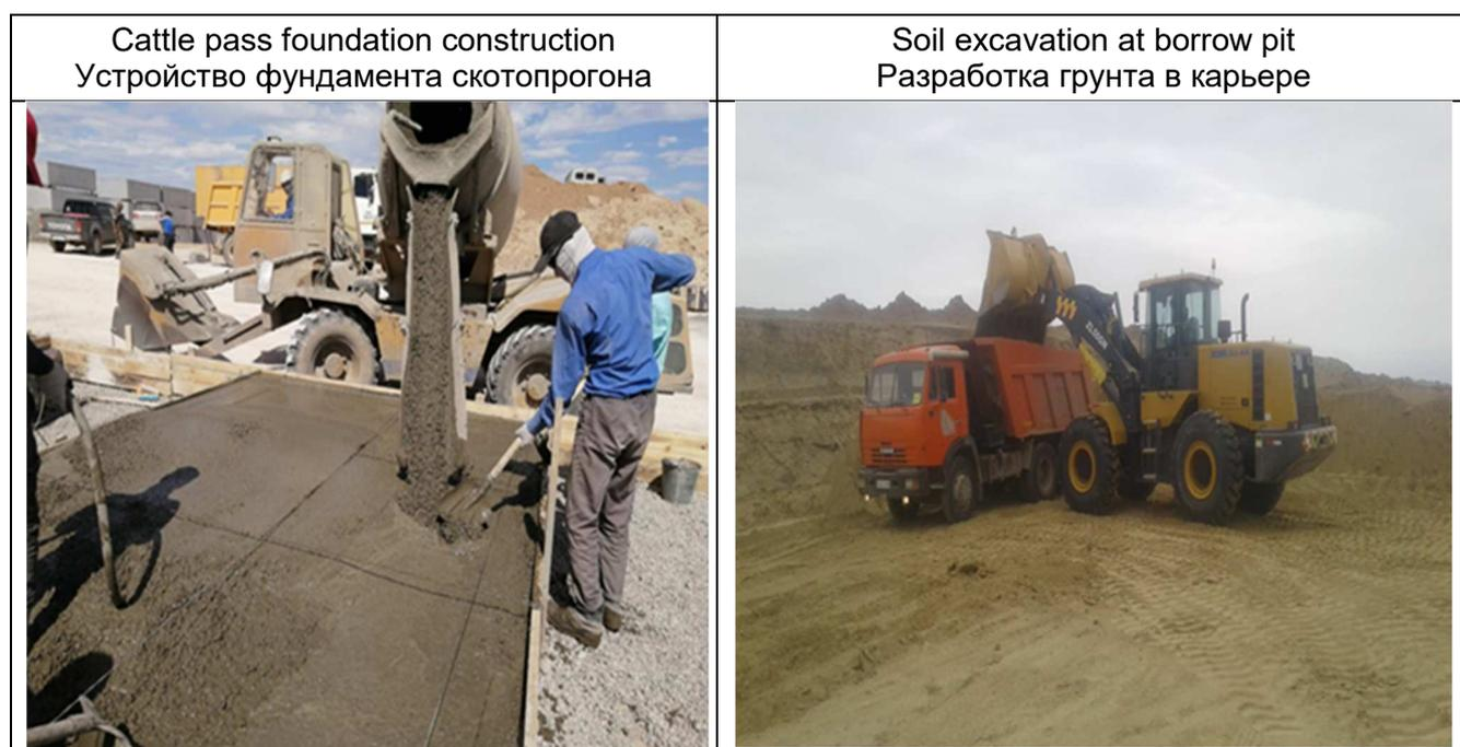
Рисунок 4. Дорожные работы на участке Лот 5: устройство фундамента и разработка грунта, 20.06.2020 г.
